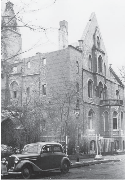
تصویر ۸۸. ساختمان آسیب‌دیده مؤسسه در خیابان مارین، برلین.
